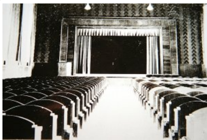
Sala kinoteatralna w głównym budynku dydaktycznym. Widok na scenę. Lata `30. XX. wieku.
