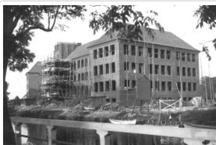
Budowany obiekt szkoły dla dziewcząt z dobrych domów - szkoła Lesinga. Lata `20. XX. wieku
